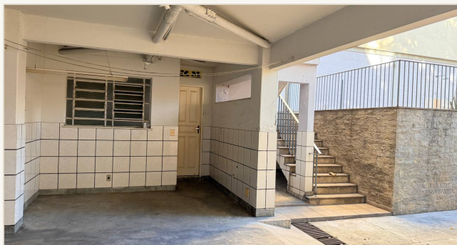
VÃO DE GARAGEM E CIRCULAÇÃO VERTICAL AOS PAVIMENTOS SUPERIORES.
